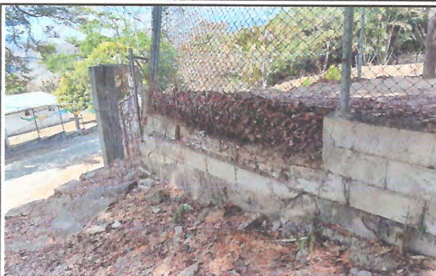
Foto 1: Mejoramiento de Reparación de muros de contención.
