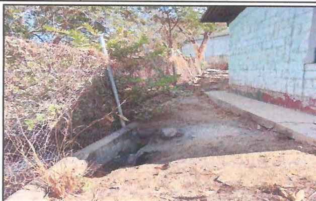
Foto 2: Mejoramiento de Reparación de muros de contención.
